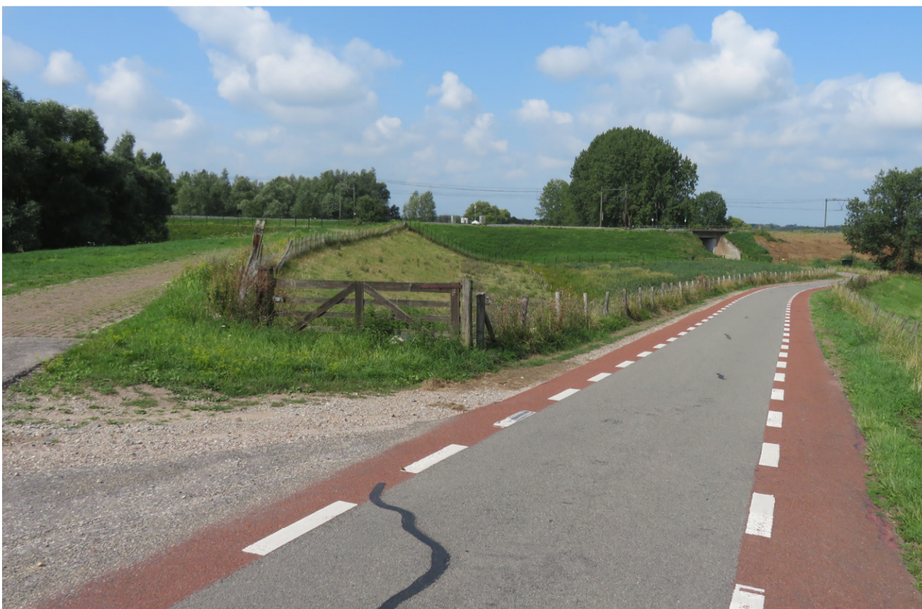
De dijk kruist hier met het spoor. De dijk wordt onderbroken en gaat onder de brug door.
