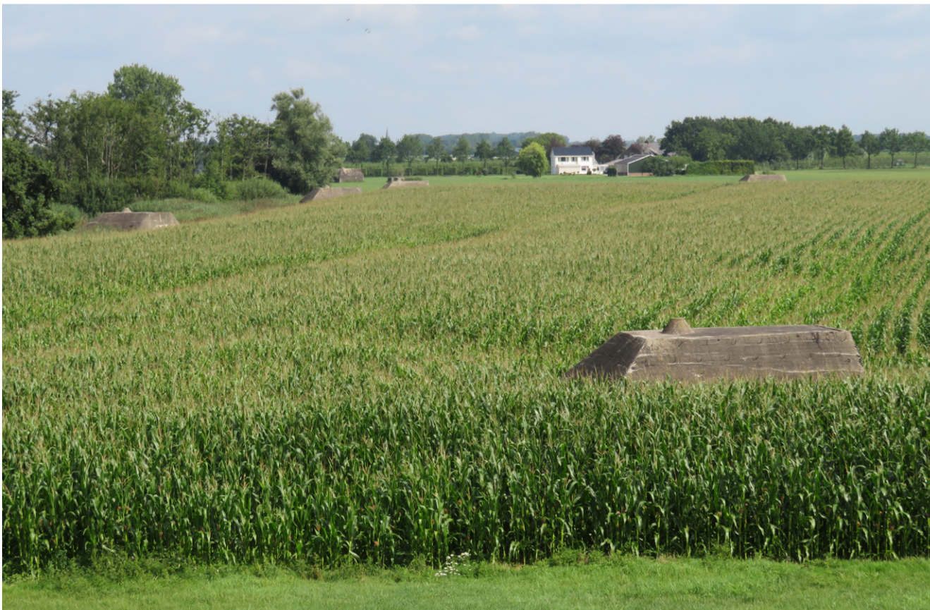
Het Werk aan de Groeneweg is goed te zien vanaf de dijk. Dit vormt een recreatief punt langs de dijk
