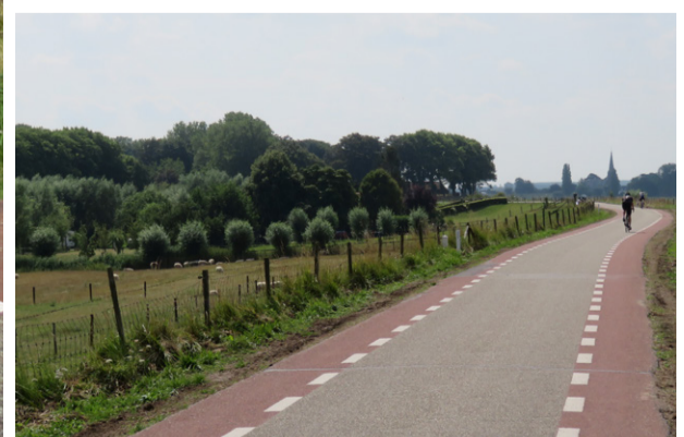
De dijk langs het inundatiekanaal is zichtbaar
