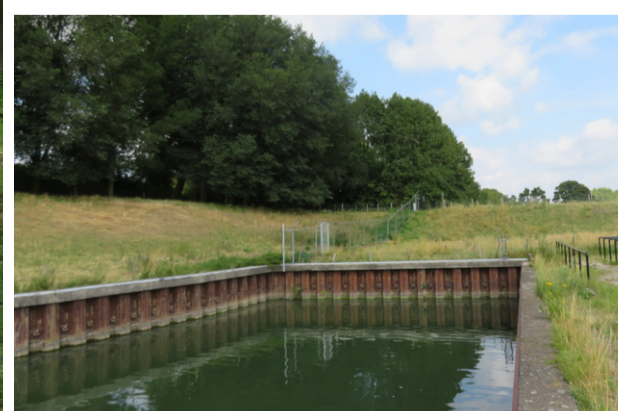
De voormalige inundatiesluis bevond zich hier
