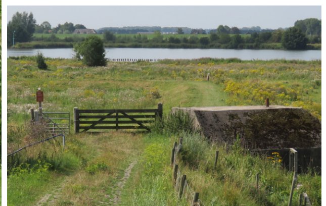
Het Werk aan de Groeneweg is een rijksmonument
