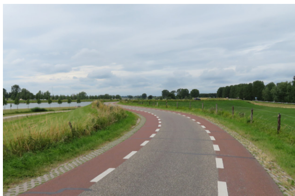
2. Bocht ter plaatse van voormalig dijkmagazijn
