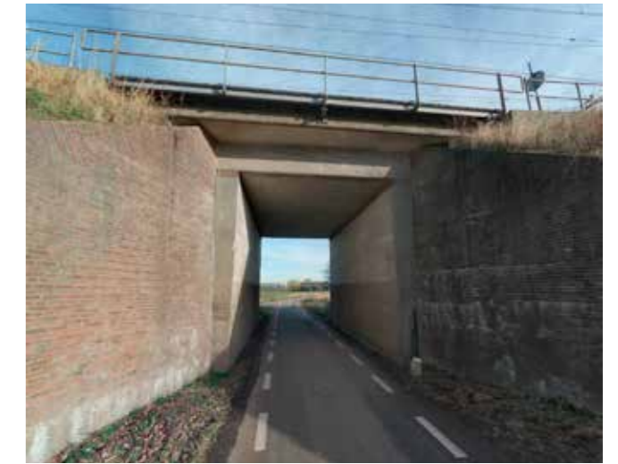
Fig 9 | Lekdijk, ter hoogte van de tunnel onder de spoorweg
