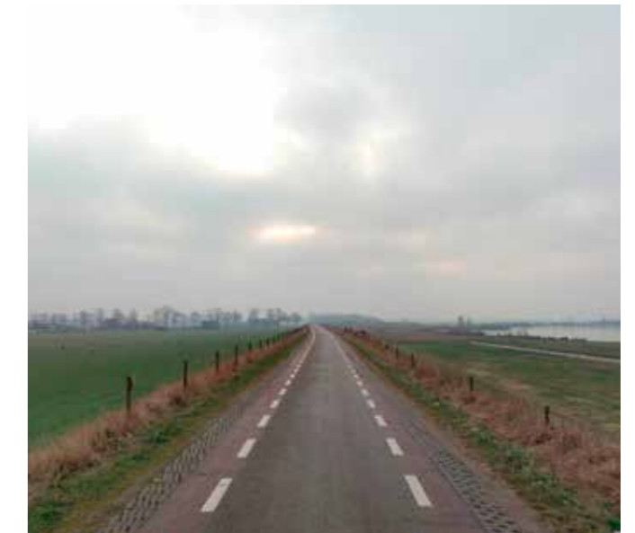
Fig 7 | Lekdijk, ter hoogte van de Lange Uitweg
