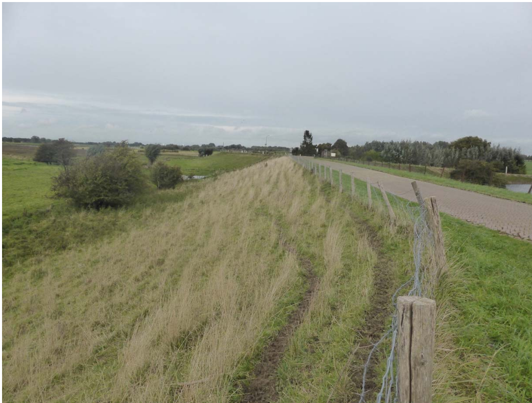
Figuur 7—2: Groene dijk met toegangsweg naar Fort Honswijk
