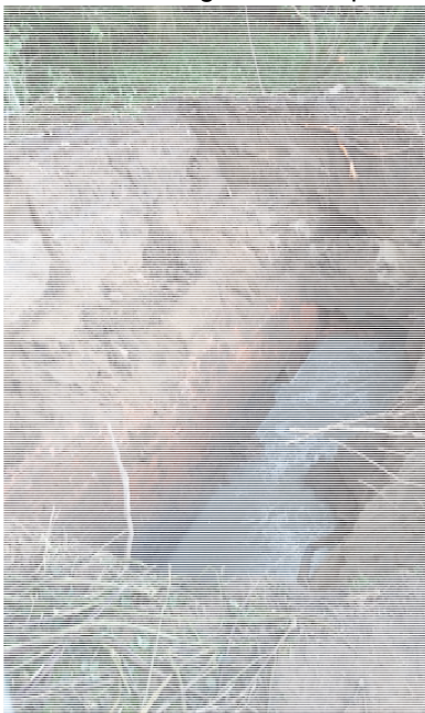
Figuur 5—2: Afwateringsriool vrij gegraven
