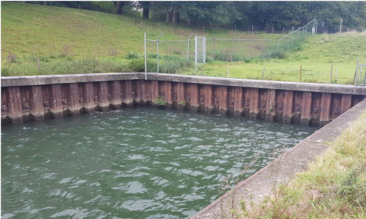
Figuur 4—7: Damwandconstructie verholen inundatiesluis
