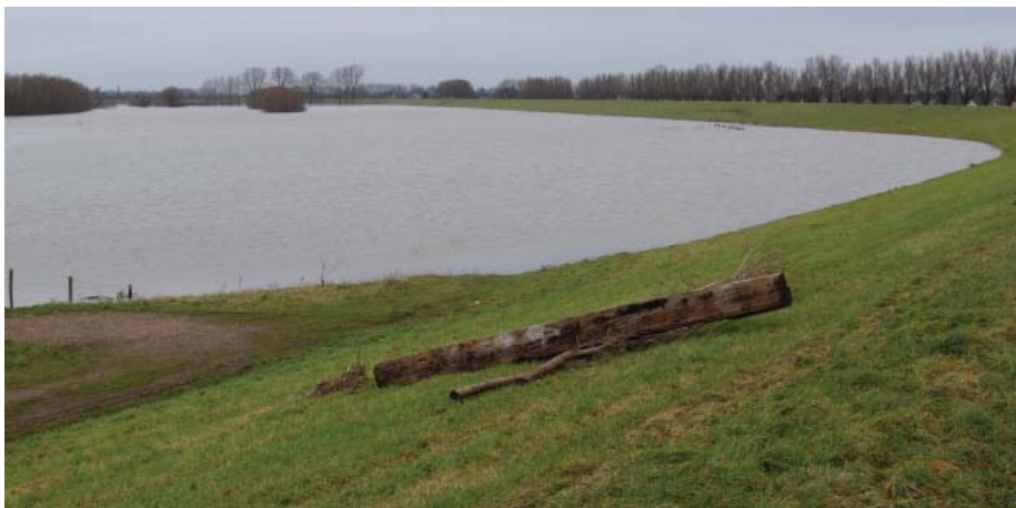
Inlaagdijk in Herwen, gebouwd om de Noorder Lekdijk te behoeden voor een catastrofe.
