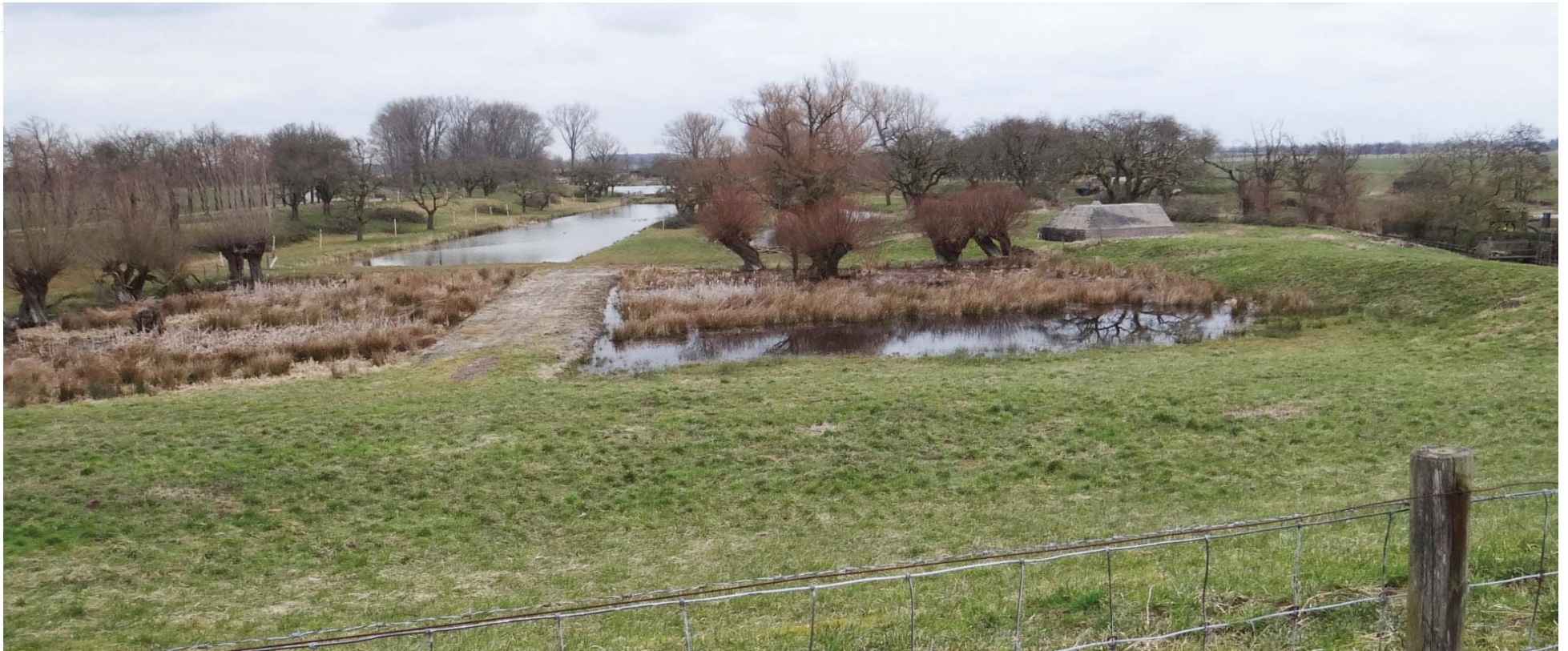
Werk aan de Groene Weg aansluitend op de Lekdijk.
